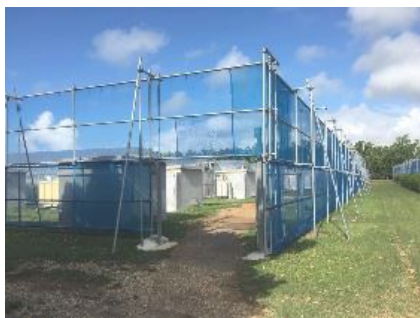
防風ネットの設置
